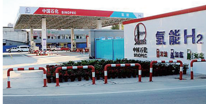
湖北省十堰市首座综合能源站近日顺利建成投运,能源站以氢能为主,集充电、光伏发电、加油等多种新能源为一体,市民可根据车辆燃料不同在此选择加油、加气、充电等服务。
