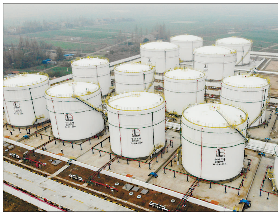
1月16日,国内成品油销售行业最先进的油库——中国石化荆州油库正式投用。据了解,中国石化荆州油库的前身位于长江荆江河段岸边200米处,油库码头距离居民饮用水取水口约800米。2018年6月,根据要求油库需易地搬迁建设。中国石化湖北石油分公司先后关停8座沿江油库,并投资4.24亿元异地新建了荆州油库。荆州油库按照绿色环保、智慧智能、安全先进的设计理念,实现了收油、发油、环保、消防和安防各环节的智能化建设。
