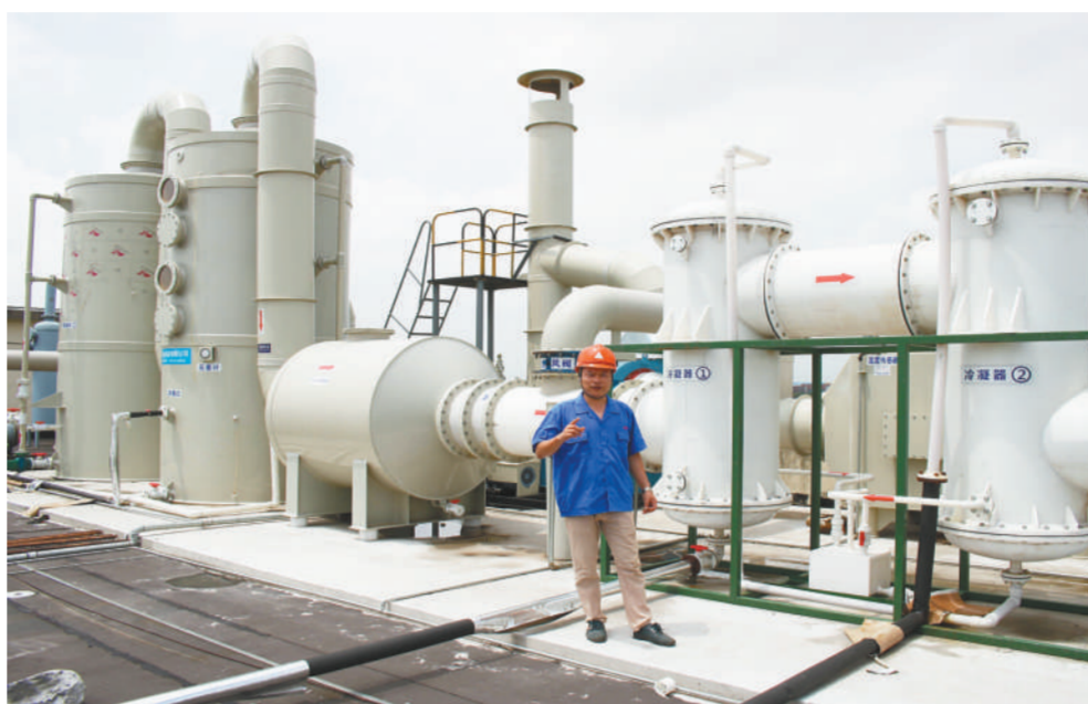
▲图为企业安装废气治理设备。
