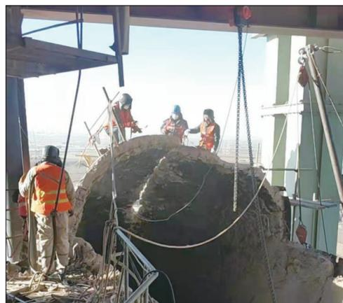
施工人员拆除分解炉上部现场。
