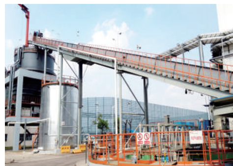
图为常州市国能污泥处置项目现场。
