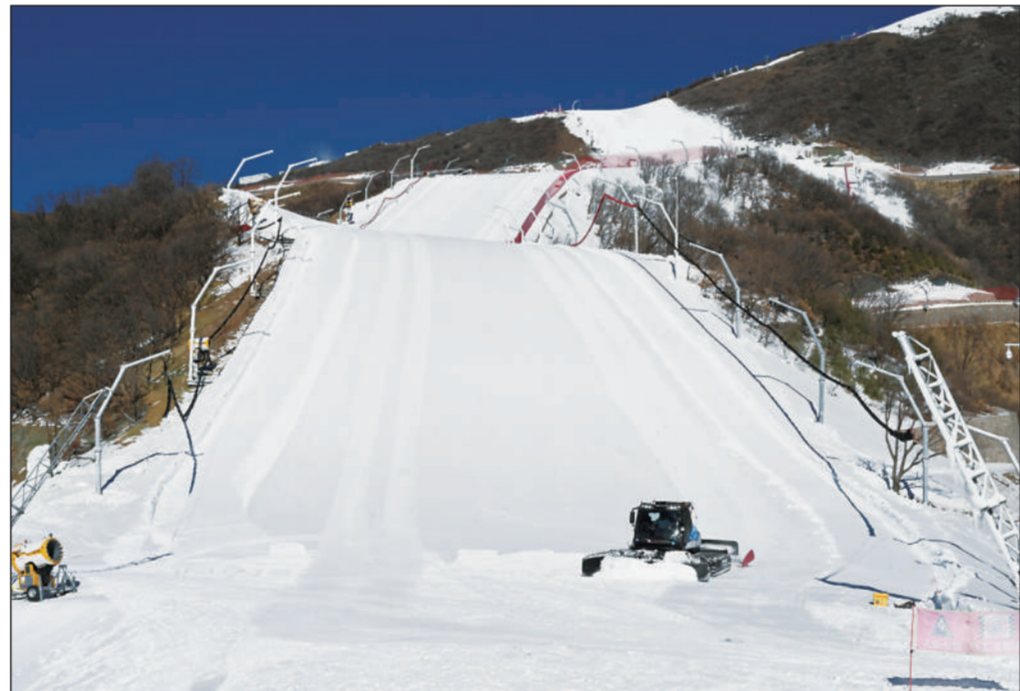
高山滑雪项目被誉为“冬奥会皇冠上的明珠”。位于北京延庆的国家高山滑雪中心是国内首个符合冬奥会的高山滑雪比赛场地。延庆赛区是冬奥场馆建设史上建设周期最短、施工难度最大、建设标准最高的赛区之一。延庆赛区的裸露地面经过土石植被处理,使地表水、雨水、融雪水入渗和滞留,减缓了水土流失。在造雪用水管理方面,延庆赛区采用了智能化造雪系统,实现水资源的优化配置和精准投放。
