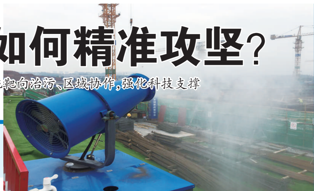
图为施工工地正在进行洒水降尘。 沙坪坝区生态环境局供图
