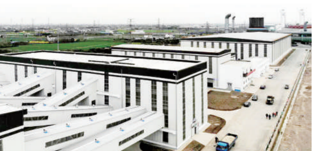
图为沙钢集团五千河钢渣加工处理线项目,采用中冶环保钢渣磁选线,年处理能力达330万吨。
