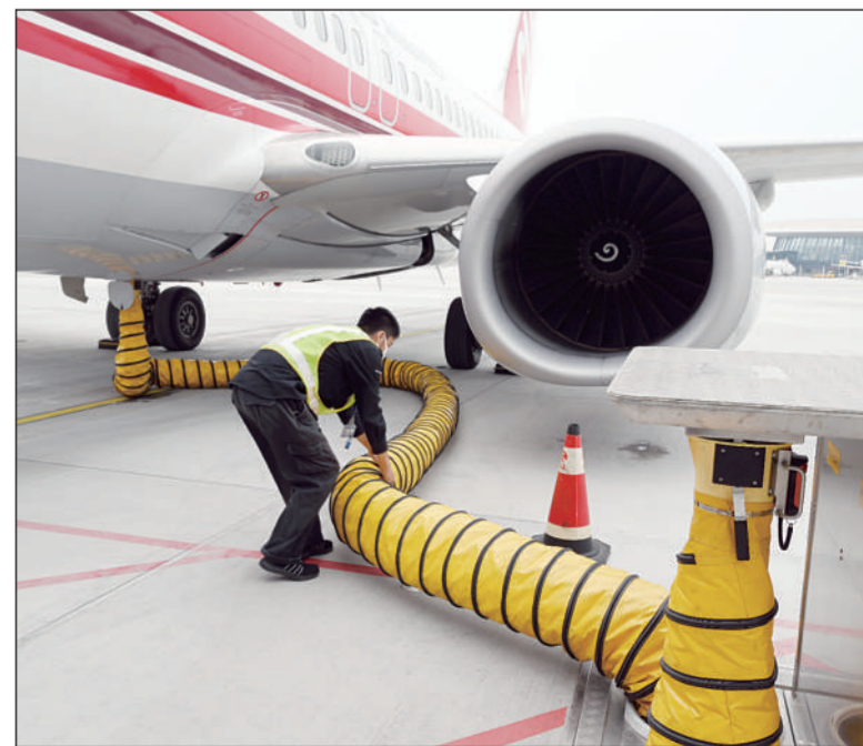
全国政协委员、春秋航空董事长王煜建议,建立“国内机场绿色发展评价标准”,通过机场可再生能源利用率、建筑运行阶段的碳排放量、飞机辅助动力装置(APU)替代设备使用率等指标,对机场的减排表现进行详细评价,促进机场各方面做好降碳减排工作。图为北京大兴国际机场工作人员通过挂载在廊桥的地面电源和空调机组设备向飞机供电供气。
