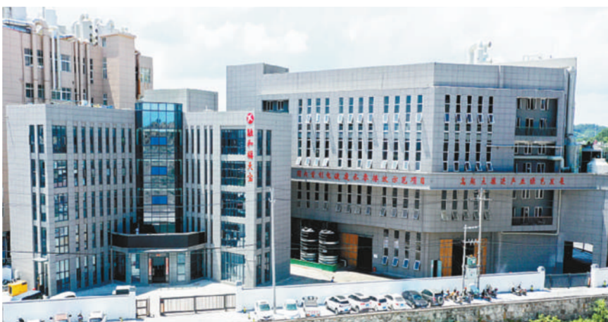
玉环福天宝沙门电镀废水零排放水厂
