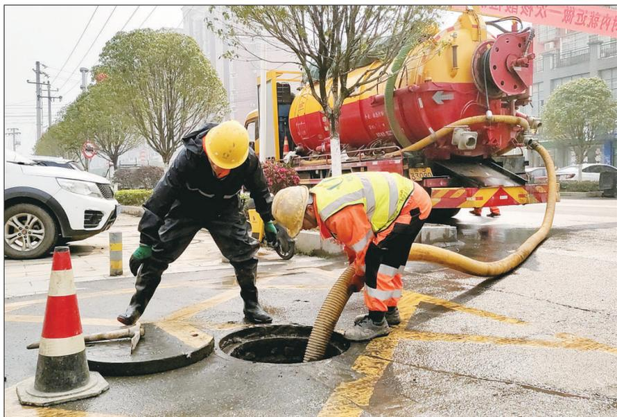
江西省万载县近日组织执法人员、聘请第三方专业公司,对污水管网、饮用水源地、危险废物贮存区、垃圾焚烧发电厂等高风险敏感领域及污染防治设施,开展排查整治,并强化监测预警。图为工作人员正在对城市管网进行清淤、检测、维护。 冯万 张林霞摄
