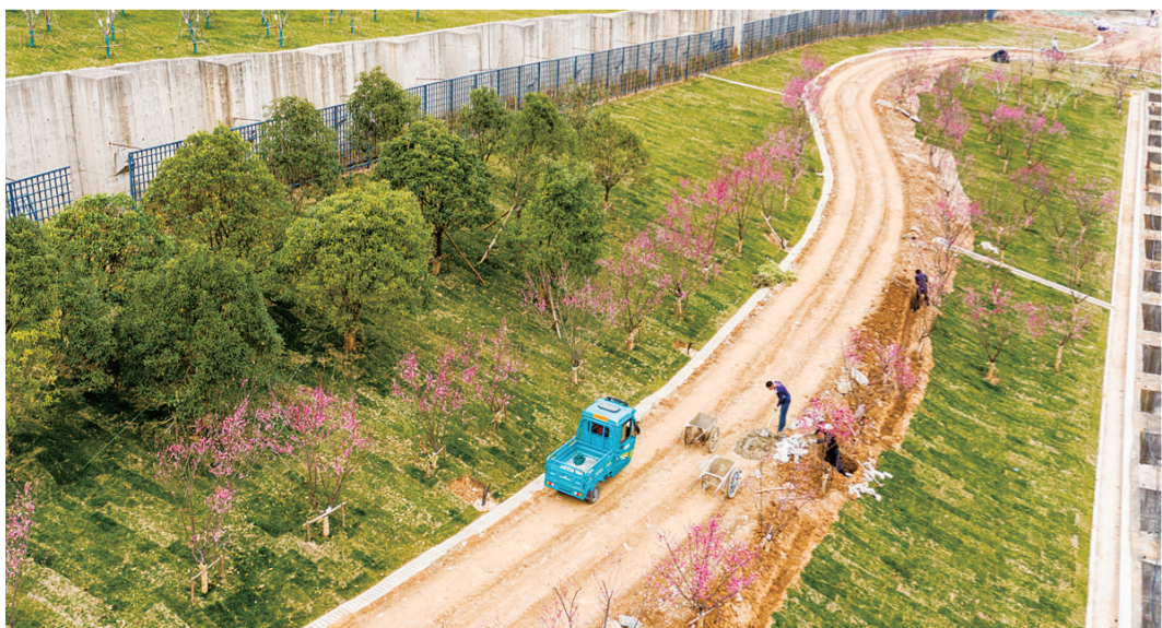
近日，在安徽省芜湖市繁昌区峨山沿山景观休闲带工程工地上，工程建设者正在施工作业。近年来，繁昌区对废弃矿山实施整治、水土保持、生态修复等工程，让昔日满目疮痍的废弃矿山成为市民亲近自然的好去处。
