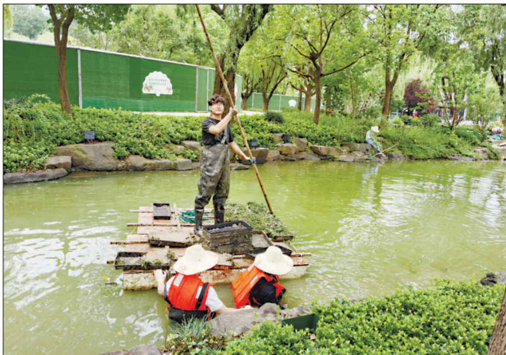
图为工作人员在南湖水生态修复示范区现场种草皮。
