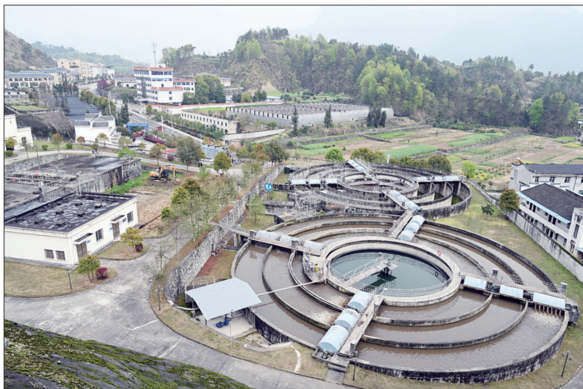
有着“坝头库首第一村”美誉的湖北省宜昌市太平溪镇许家村紧邻三峡大坝左岸,近年来积极推进美丽乡村建设,建设污水处理厂和5000余米污水管网,实现生产生活污水集中处理,防洪排水排污设施全面提标;建立户分类收集、村统一转运、镇集中处理的垃圾分类处理机制,实现垃圾日产日清。本报记者邓佳摄
