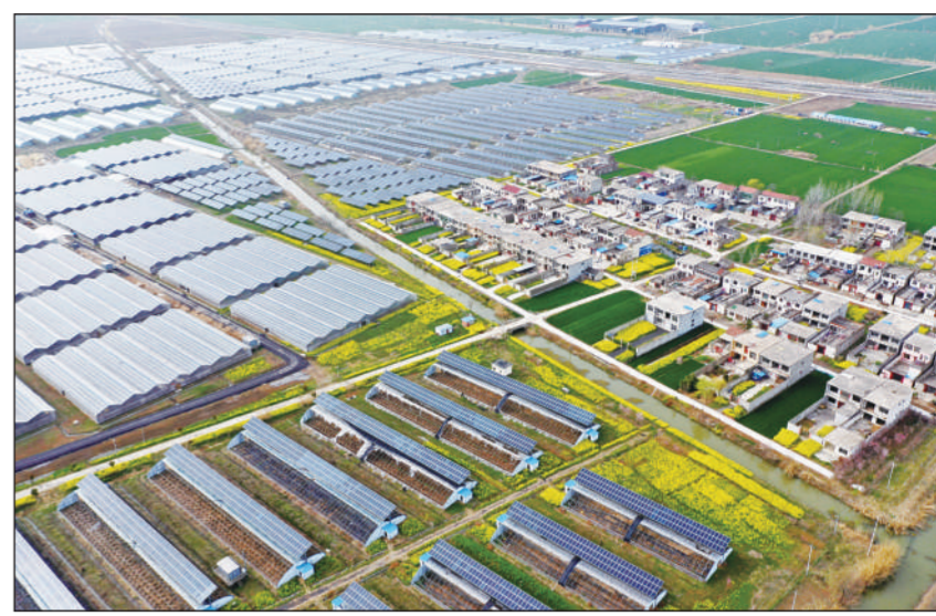
眼下正是春暖花开的季节,安徽省亳州市蒙城县成排成组的光伏电站,在村庄、油菜花及麦苗的映衬下,犹如一幅美丽的图画,镶嵌在绿色的平原上。据悉,目前蒙城县共建设光伏帮扶电站366座,总装机规模76335.2KW,分布在全县16个乡镇265个行政村。2021年发电量9588.47万千瓦时,等效利用小时数1256.1小时,为乡村振兴增添了绿色动能。
