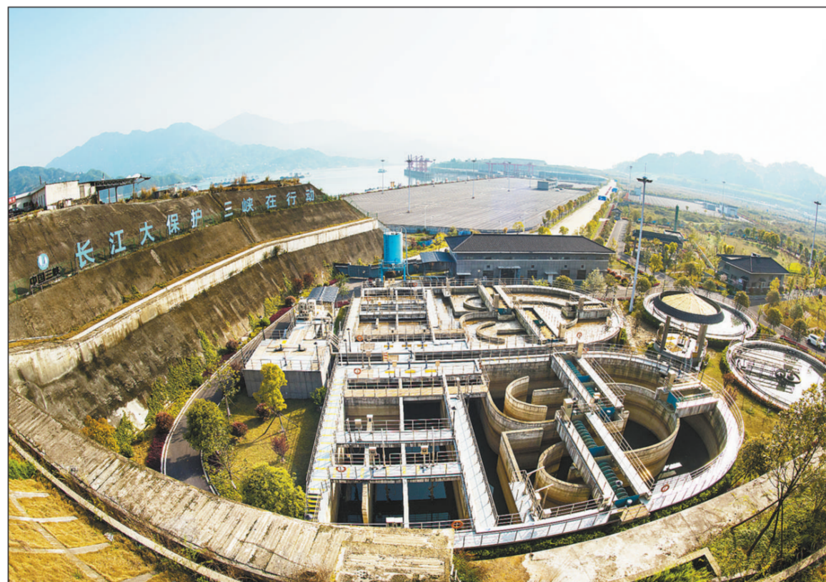
位于三峡大坝上游的湖北省宜昌市秭归县曲溪污水处理厂是三峡集团长江大保护宜昌示范区先导项目,于2018年9月开工建设,2020年1月开始运行。项目服务范围涵盖秭归县城红城新区、三峡翻坝物流产业园、三峡屈原文化生态旅游度假区等区域,服务人口7万人。据了解,项目的投运改善了秭归区域长江水体环境,对治理长江水污染、保护三峡水库水质和生态平衡产生了积极影响。
