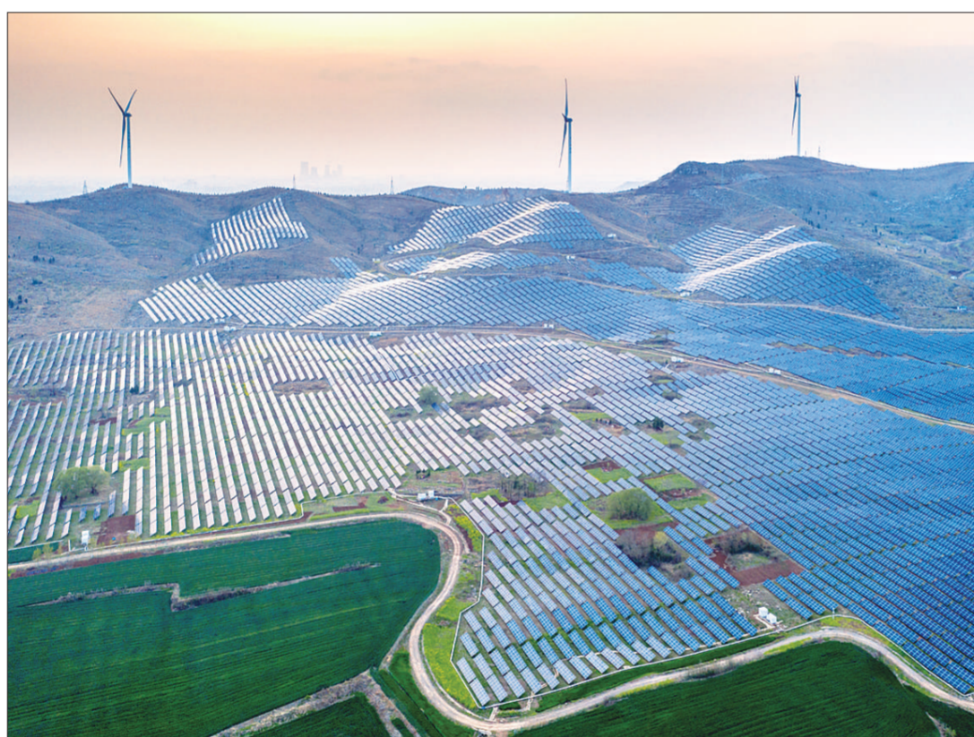
安徽省宿州市埇桥区大力推进“新能源+新农村”互补扶贫模式,利用荒山荒坡,建设风力发电及光伏发电项目,挖掘资源优势,延伸产业链条,培育贫困山区造血功能。图为埇桥区符离镇张楼村西山清水风电场及光伏发电项目。 人民图片网供图
