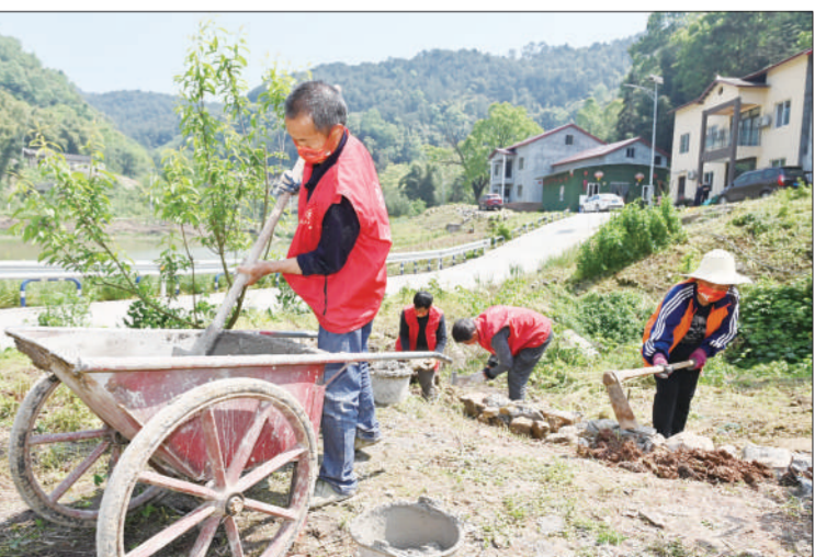
近日在昌吉市沙坪坝区青木关镇四棵碑村,党员志愿者与村民正在进行农村人居环境整治施工。沙坪坝区突出“党建+”农村人居环境整治提升模式,全力做好辖区农村人居环境整治工作,助力乡村振兴。 孙凯芳摄
