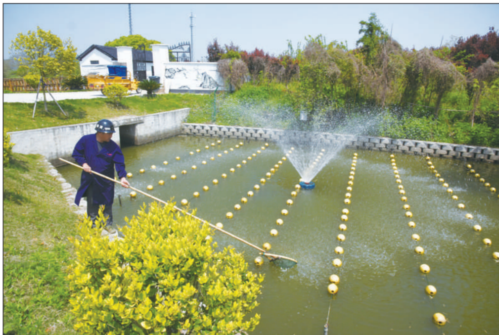
浙江省德清县下渚湖街道和睦村坝头港尾水治理点的工作人员在清理水中漂浮物。“五水共治”开展以来,德清县为治理养殖尾水,通过建设“两条过滤坝+沉淀池、曝气池、生物净化池、人工湿地”的治理模式,利用水生动植物、微生物的生态作用,确保养殖尾水能够循环利用或达到排放标准。
