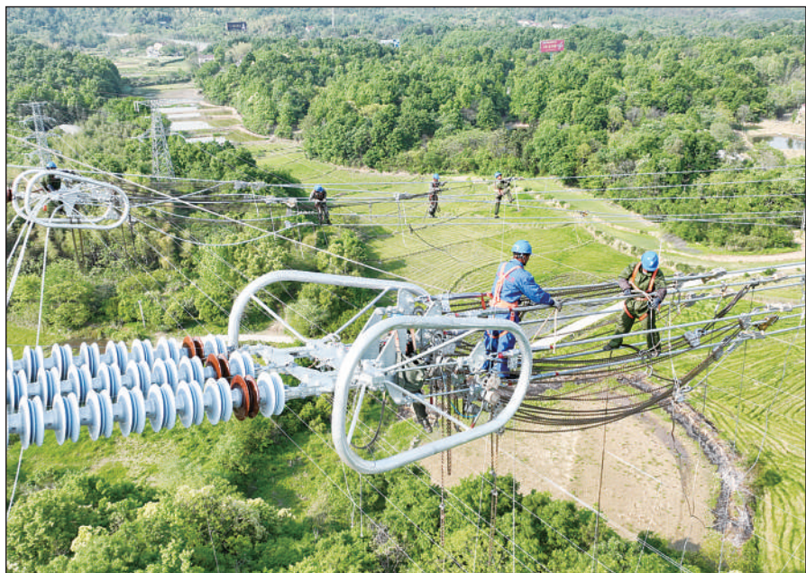
白鹤滩—浙江±800千伏特高压直流输电工程是国家“西电东送”战略部署的重点工程,建成后,将依托白鹤滩水电站将四川水电能源大规模输送至华东地区,发挥重点电网工程在清洁能源消纳等方面的重要作用。因为电力工人正在铁塔上展放导线。 人民图片网供图
