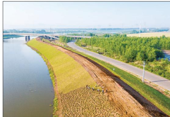
近年来,安徽省芜湖市繁昌区加大江河堤防建设力度,通过对堤防进行除险加固、生态修复、绿化美化,构筑安全河岸堤坝,打造美丽生态江河岸线。图为繁昌区荻港镇庆大村,民工正在黄洋河堤防上进行铺设护坡草皮施工作业。 人民图片网供图
