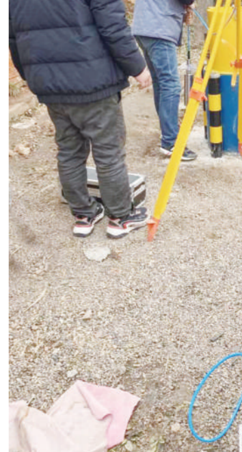
图为地下水监测现场。
