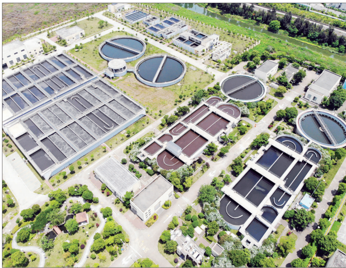
近年来,路桥区在党建引领下开展“污水零直排区”建设,把生活污水统一纳入污水管网进行净化处理,保护水资源,美化生态环境。图为近日,位于浙江省台州市路桥区全清镇的污水处理厂,净水设备正在工作中。
