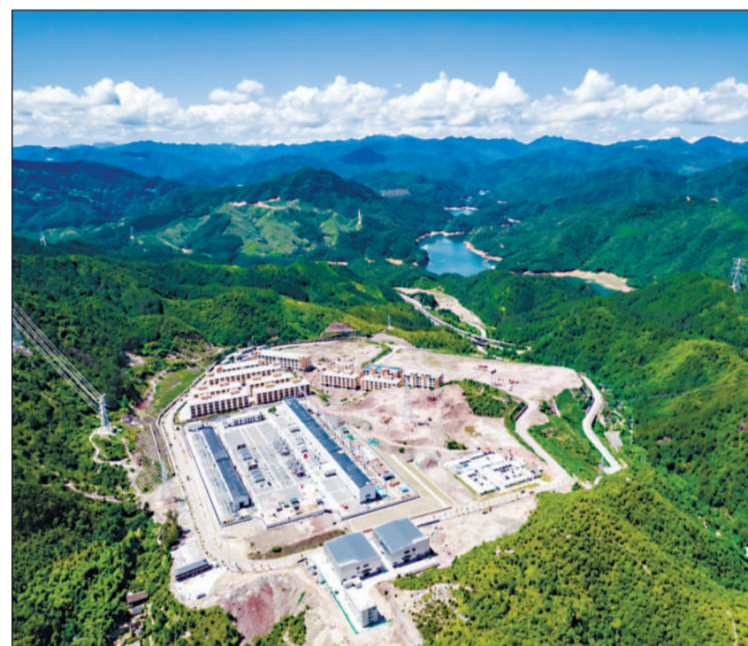
5月31日,在浙江省龙泉市安仁镇,丽西输变电工程启动投产。至此,丽水500千伏电网形成“东西互济”格局,浙西南清洁能源“出山”有了大通道,将促进绿色能源产业发展,支持山区早日实现共同富裕。
