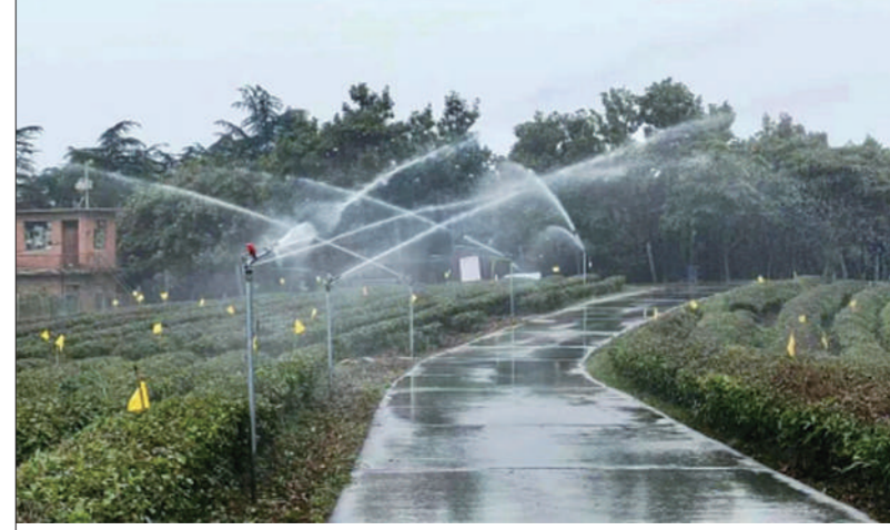
丹江口水库鱼类增殖放流站近年来专门建设污水回收利用系统,用管道将增殖放流站与松涛山庄内的橘园和茶园连通,形成水循环再利用的喷灌管网,实现鱼苗孵化和橘树、茶树抗旱保苗两不误,不仅降低生产用水成本,而且做到一滴污水不外排,实现污水回收“变废为宝”。 叶相成 郑江斌摄
