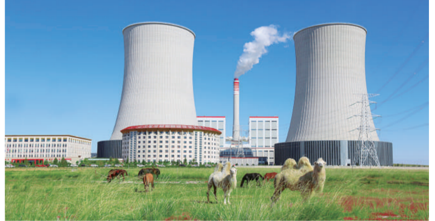
图为世界首个大型燃煤电厂零补水项目——由清新环境负责的京能五间房电厂烟气脱硫提水一体化项目。
