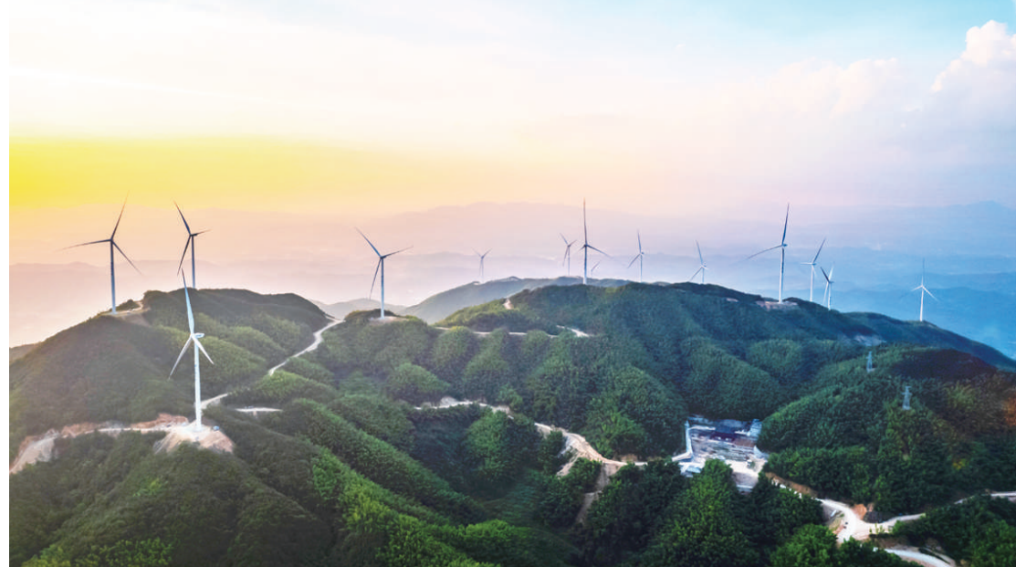
江西省宜春市袁州区丰平山云雾缭绕,宛若仙境。山顶28台风力发电机组(年发电量达1.56亿千瓦时)转动着风叶,机组可通过智能感应风力风向,迅速变航变桨,实现最大效能输出绿色能源。
