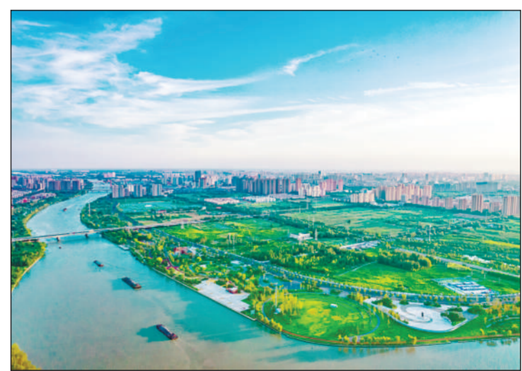
近年来,江苏省宿迁市宿豫区坚持生态优先、绿色发展,大力开展岸线生态改善、生态绿带拓展、河道堤岸护坡、堤防除险加固等运河整治工程,形成“河畅、水清、岸绿、景美”运河生态新画卷。
