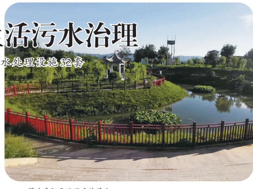
图为千阳县治理后的粪池。
