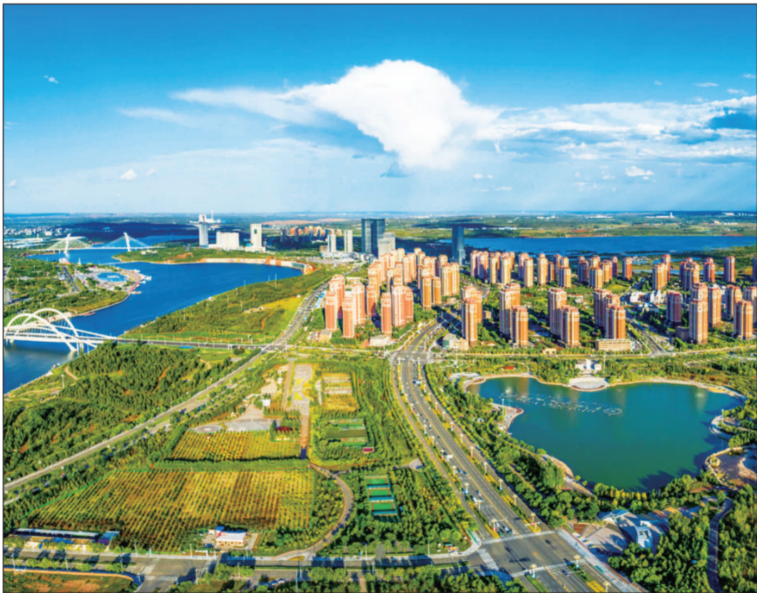
近年来,内蒙古自治区鄂尔多斯市伊金霍洛旗在开展生态文明建设过程中,持续推进煤矿疏干水综合利用工程,每年将净化达标的5000余万吨疏干水引入城区,循环用于城市生态水系、园林绿化,实现疏干水零排放,形成“水在城中、城在绿中、人在景中”的生态宜居环境。
