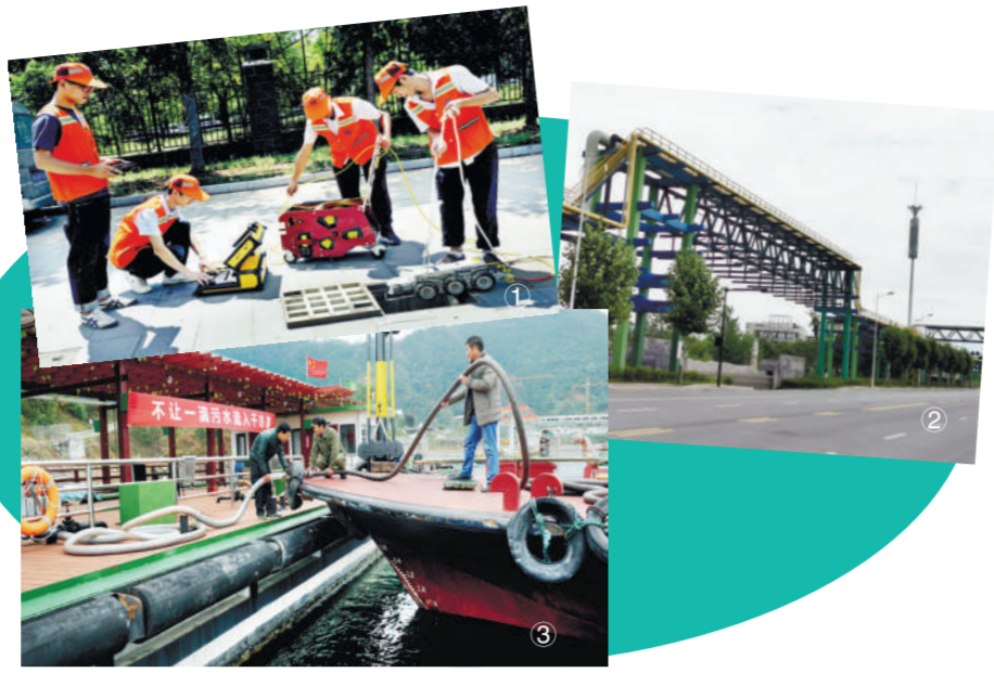
图①为工作人员运用管道机器人检测污水管网。
