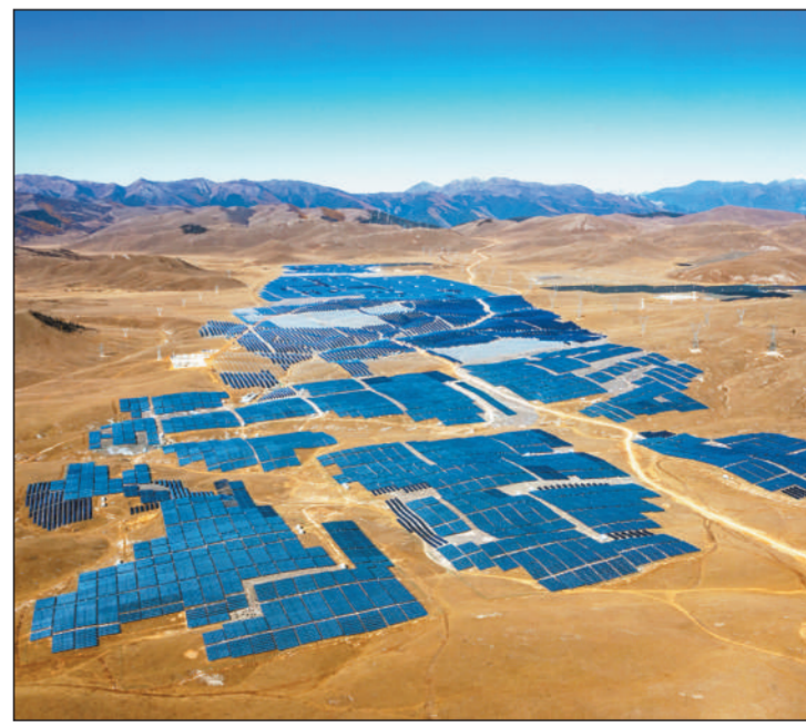
近日,超海拔光伏实证实验基地项目——国家电投兴川实证光伏电站首批发电单元并网发电,标志着基地正式投产应用。四川省甘孜州兴川光伏实证实验基地位于海拔约4000米的甘孜州正顶贡草原,总装机60万千瓦。项目总占地面积约13650亩,总投资约32亿元,全容量并网后年平均发电量为12.68亿千瓦时,每年节约标准煤约39万吨,减少二氧化碳排放约107万吨。
