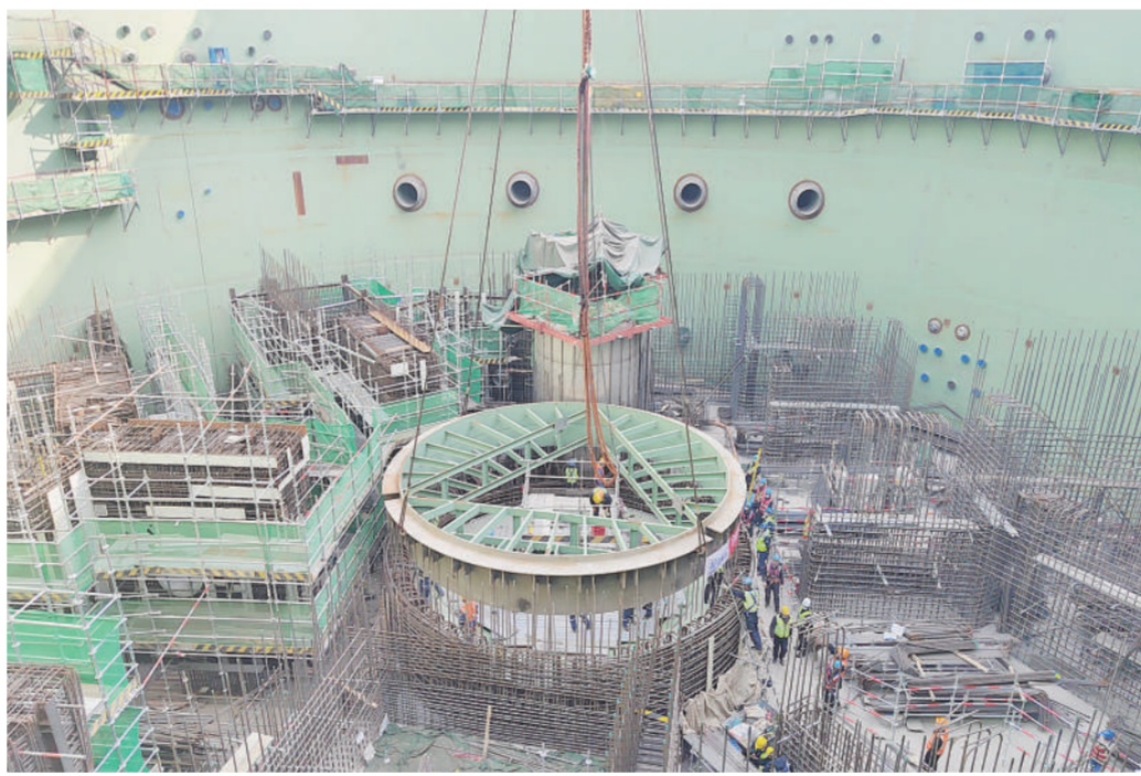
徐大堡核电3号机组压力容器支撑桁架上部预埋件组合模块近日顺利吊装就位,吊装过程安全、质量受控。中核集团供图
