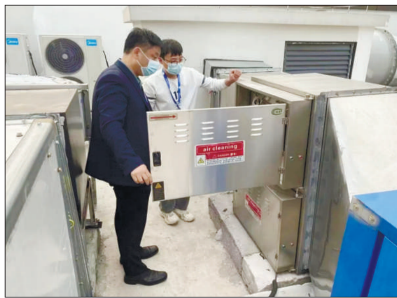
徐向荣(左一)现场检查商业综合体油烟净化器。
