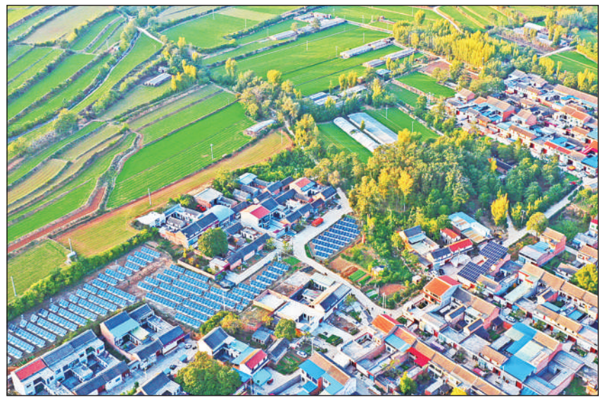
近年来,河南省孟州市大力发展清洁能源,鼓励群众利用居民屋顶、扶贫基地、企业厂房等建设光伏电站,助力乡村振兴。图为孟州市赵和镇下坡村的光伏发电项目。 人民图片网供图
