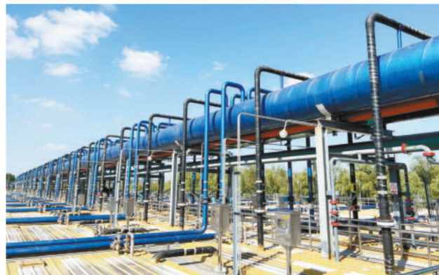
图为采用全密封结构的25000m 3 生化池。
