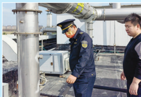
奉贤区生态环境局执法大队对排气设备开展检查。
