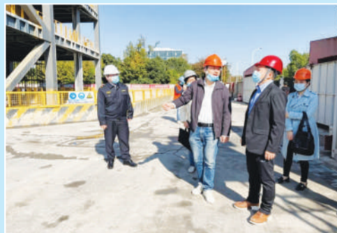
长宁区生态环境局局长马骥带队检查工地扬尘。
