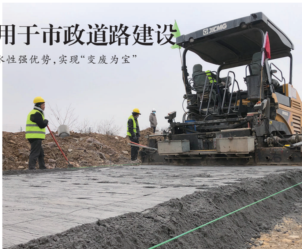
图为施工单位将无害化处理后的灰色磷石膏铺在路上。
