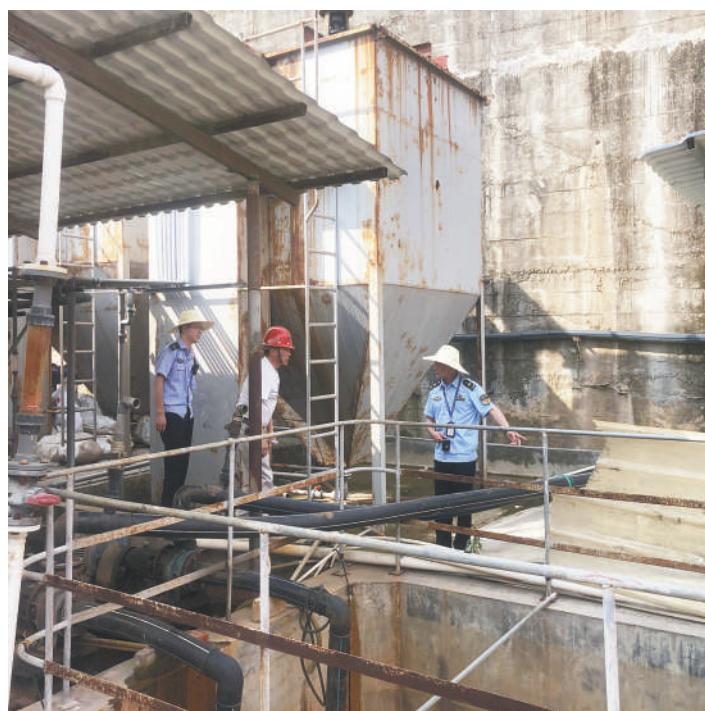
图为生态环境执法人员在现场检查管道走向。丽水市生态环境局遂昌分局供图
