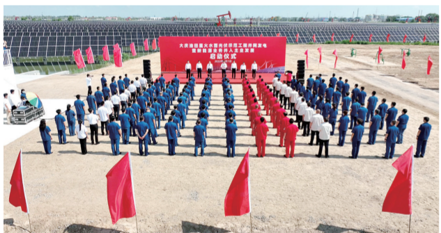
图为大庆油田星火水面光伏示范工程并网发电启动仪式现场。
