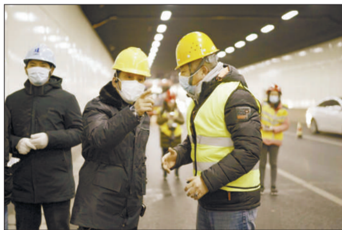
图为霍鲁宁(左二)在草场门隧道尾气净化设备安装现场协调工作。
