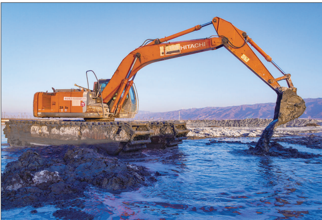
春节假期过后,山西省运城城市实施的盐湖生态修复工程开始全面复工,修复工程主要包括堤岸除险加固、河道治理、生态修复及配套基础设施建设等。
