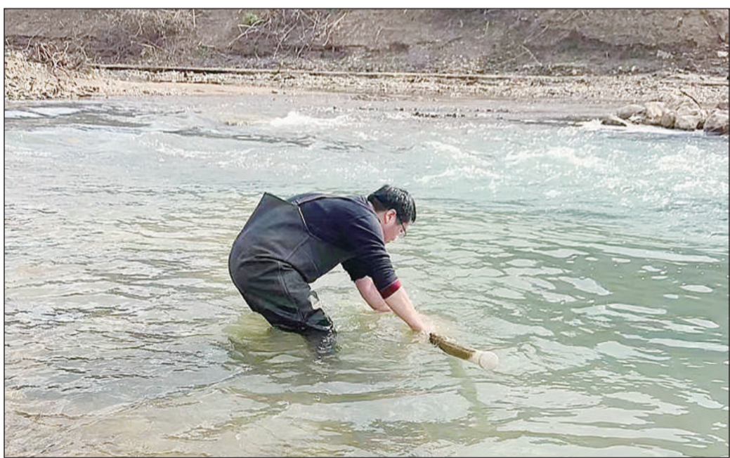
近日,江西省九江市瑞昌生态环境局全力做好洋港水质自动监测站基础保障工作,确保国考站点安全稳定运行。图为工作人员在低温水寒的条件下对堵塞的沉底式采水器进行清理。 本报通讯员李明 记者张林霞摄
