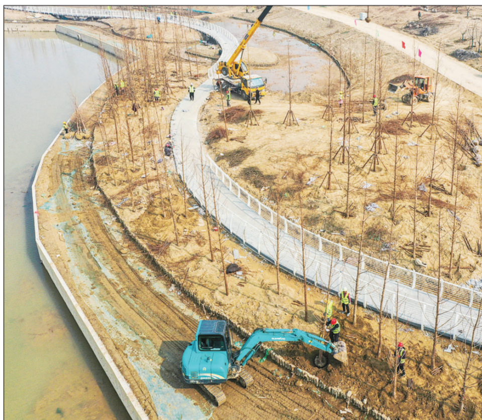
江苏省宿迁市泗阳县龙窝潭生态缓冲区项目,将原本直接排入黄河故道的城南污水处理厂尾水,通过管网接入生态缓冲区,利用自然水体和生物技术手段进一步净化处理,达到IV类水标准后,作为灌溉用水循环使用。图为工人们正在开展绿化种植等工作。
