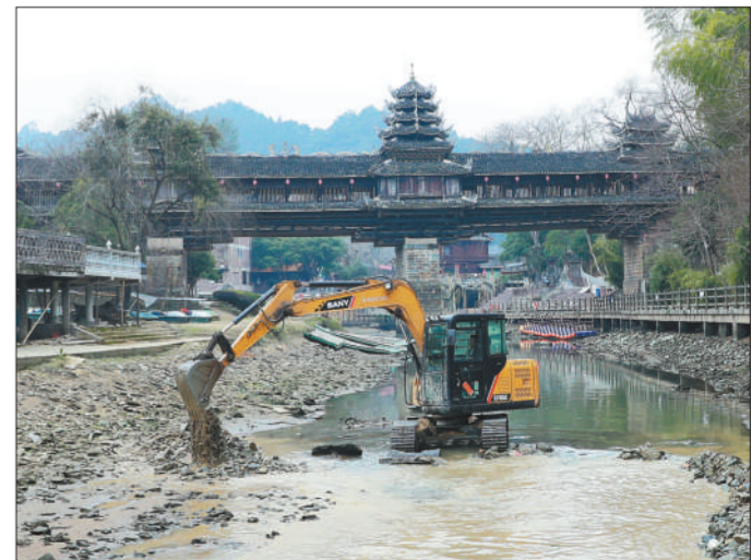
近年来,湖南省怀化市通道侗族自治县以分段式、区域性方式进行河道治理,疏浚淤泥、清除障碍物、清理垃圾、整治岸线,推动水生态环境持续改善。图为挖掘机在河道上清淤疏浚及开展生态修复作业。 人民图片网供图
