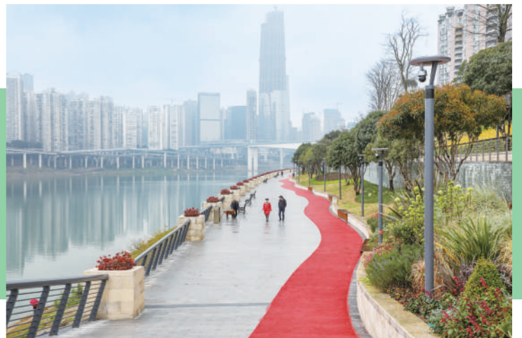
相国寺码头整体提升工程项目二期基本完工。曹检摄
