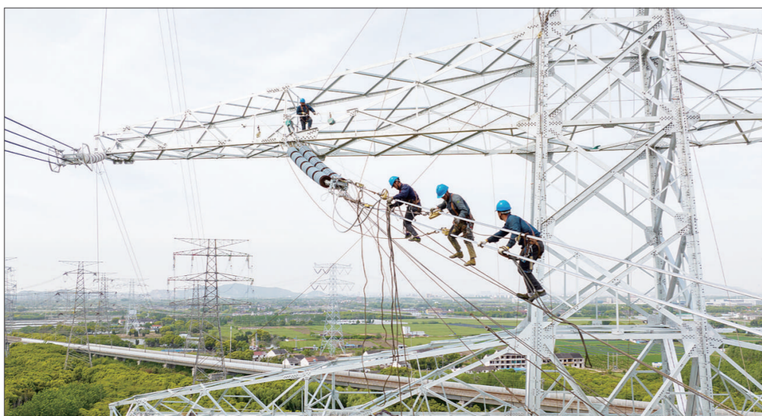
江苏凤城—梅里500千伏线路工程是江苏省内一条北电南送的主要通道,能够将苏北地区的光伏、风能等清洁能源送往苏南用电负荷中心,工程建成后,将有效提升长三角地区能源使用占比,降低长三角地区总体碳排放水平,全力支持长江两岸经济社会发展。图为线路工程建设现场,电力建设者们正在进行导线附件安装工作。
