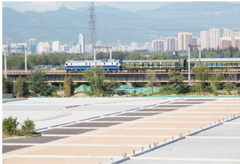
图为北京永定河京西流域生态修复工程现场。李焯摄
