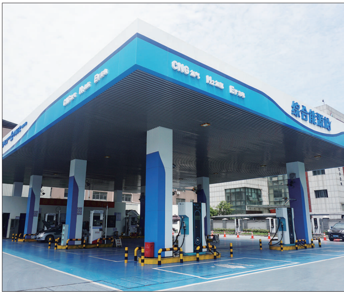
近日,浙江杭州首座以绿氢为示范、“氢、电、天然气”三位一体的绿色交通综合能源站投入使用,为助力“绿色亚运”和城市交通的零碳(低碳)能源提供了保障。
