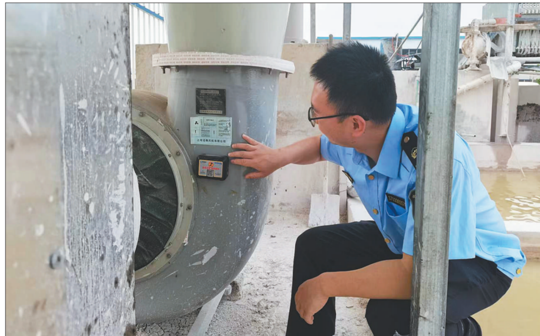
执法人员现场检查设备
