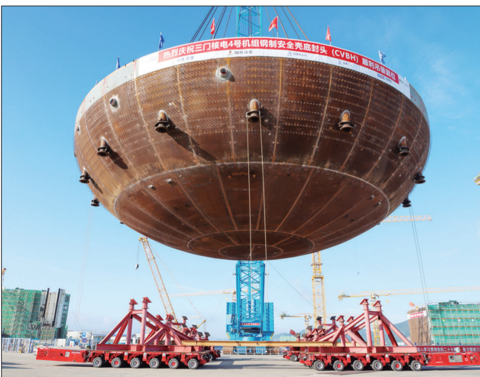
近日,在浙江省台州市三门县,中核集团旗下中国核电投资控股的三门核电二期工程4号机组核岛钢制安全壳底封头(CVBH)顺利吊装就位。三门核电二期工程4号机组建成投产后,年发电量预计可达400亿千瓦时,相当于每年减少排放二氧化碳3000万吨,将有力推动浙江省产业结构和能源结构优化。 人民图片网供图
